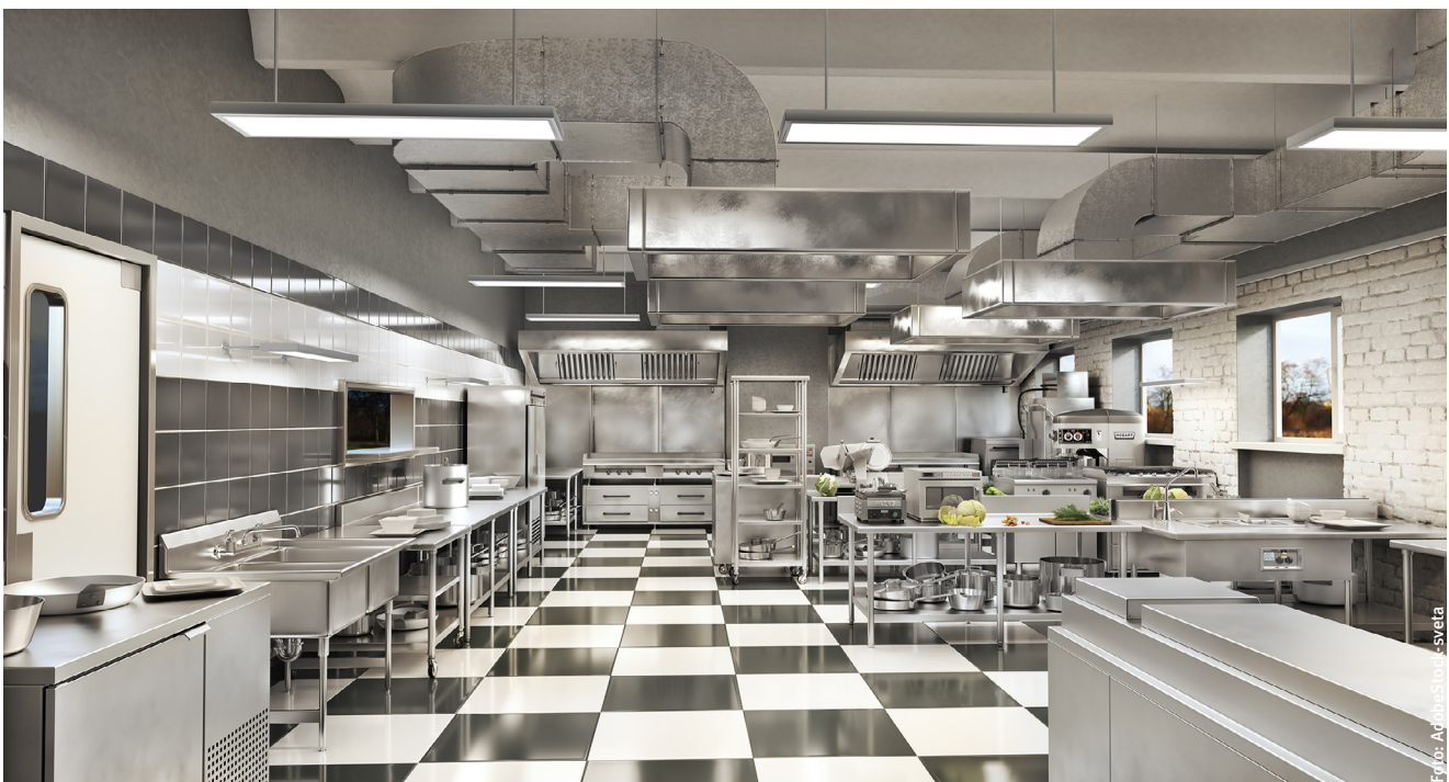
Küche mit Entlüftungsanlage
