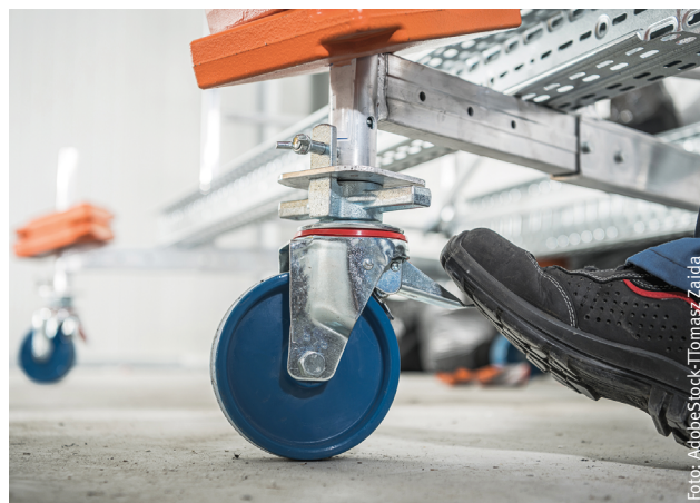
Unmittelbar nach dem Aufbau und vor jeder Verwendung die Bremsen aller Räder am Rollgerüst feststellen
