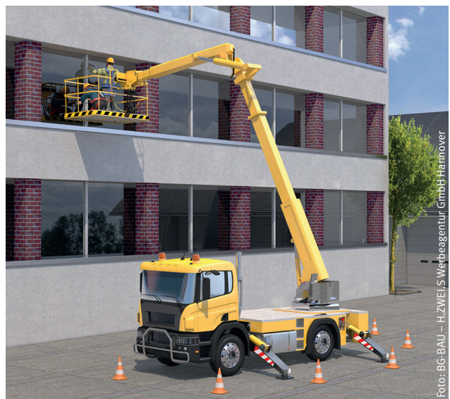
Montagearbeiten an einer Fassade mit Hubarbeitsbühne
