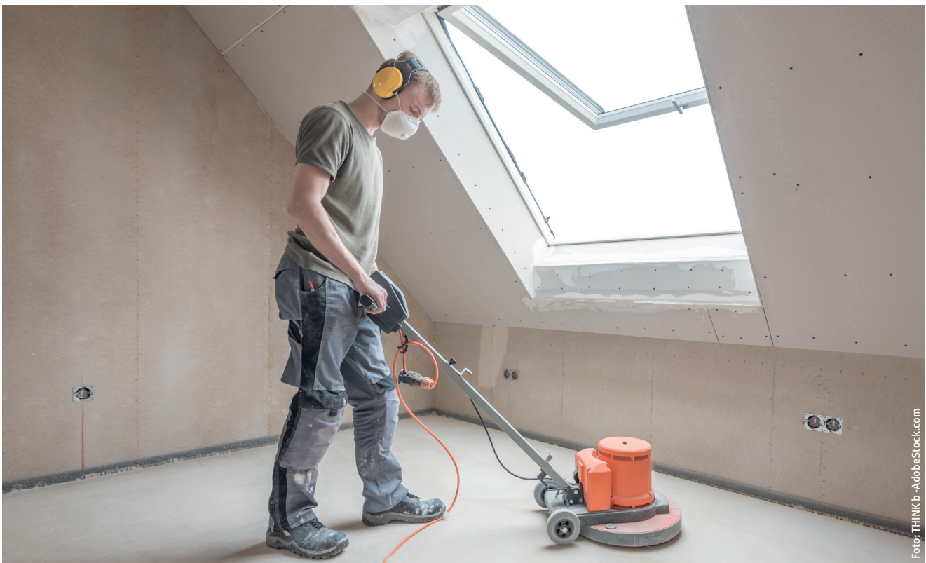
Beispiel einer mechanischen Nachbehandlung, hier bei einem neuverlegten Fußboden
