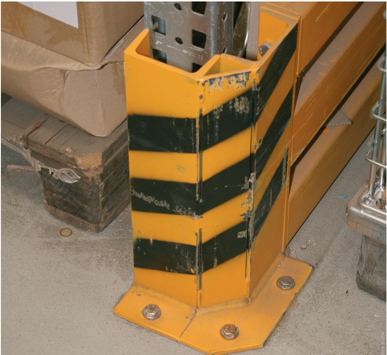
Anfahrerschutz vor der Eckstütze eines Regales
