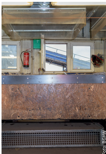
Zuführung von Frischluft oben, Absaugung im Bodenbereich
