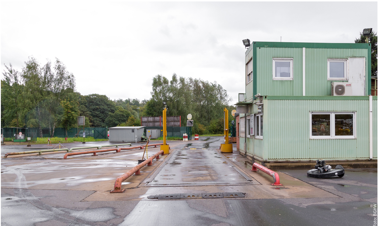
Klar gegliederter Zufahrtsbereich mit Fahrzeugwaage und Detektoren für radioaktive Strahlenquellen
