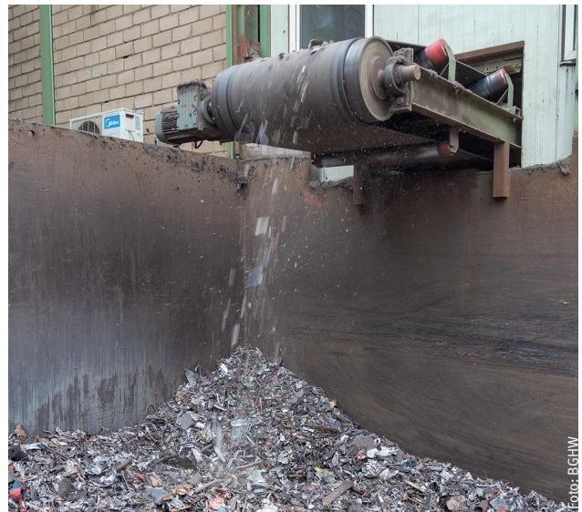
Abtrennung zur Lärmreduzierung und Materialseparation
