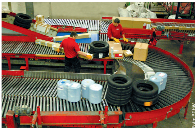
Rollenförderer in einem Verteilzentrum
