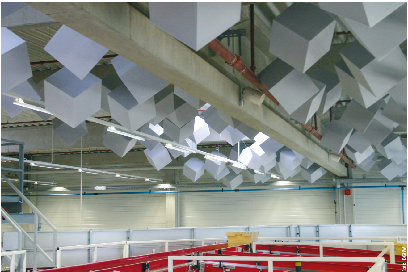
Schallabsorber in Würfelform zur Verbesserung der Raumakustik
