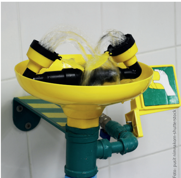
Mögliche Erste-Hilfe-Maßnahme bei Augenverätzungen durch Säuren oder Laugen: Augenspülung an der stationären Augendusche
