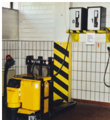
Abbildung 6: Batterieladestationen
