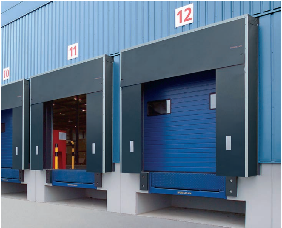
Bild 9a: Verladeanlage (Außenansicht)
