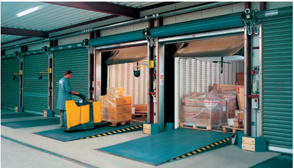
Bild 9b: Verladeanlage (Innenansicht)
