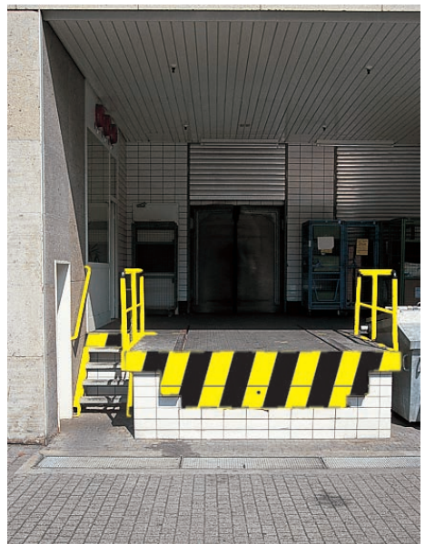
Bild 3: Treppe als Rampenabgang
