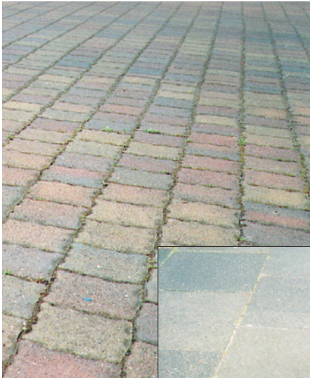
Bild 2: Bodenbeläge für Außenbereiche: Verbundstein-Pflaster, Betonplatten
